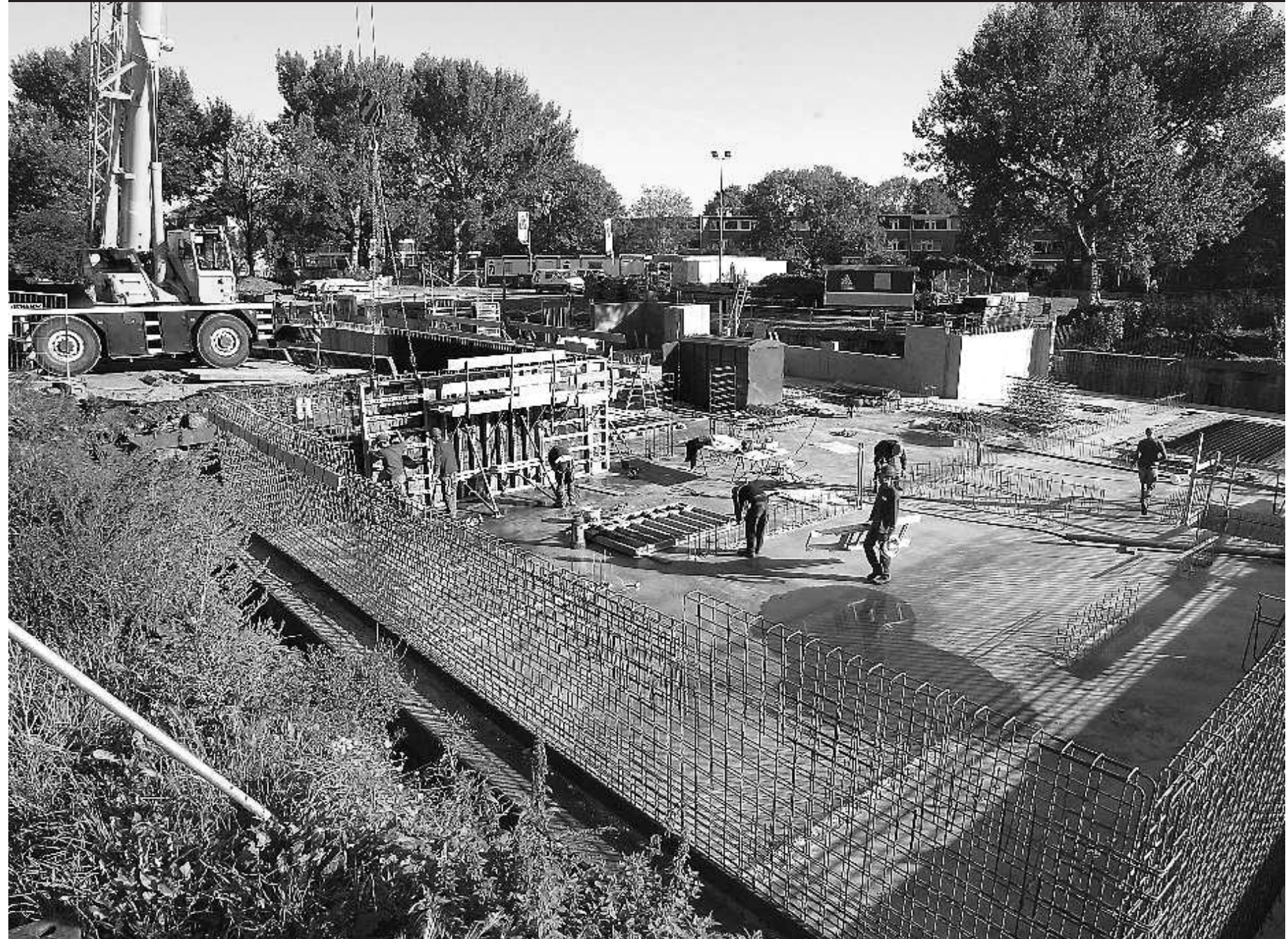
ZOETERWOUDE - Op het Loetheveld in Zoeterwoude wordt gewerkt aan de halfverdiepte garage voor de toekomstige bewoners van 'Villa Loethe' en 'Residentie Veldzicht'. De twee gebouwen worden met elkaar verbonden door deze garage, waarin 42 parkeerplaatsen en 29 bergingen komen.
